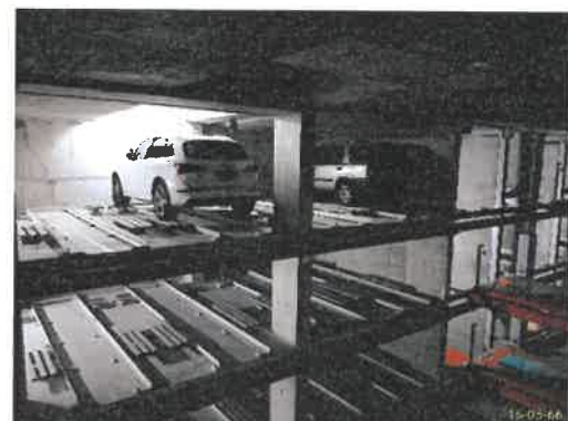
ระบบที่จอดรถอัตโนมัติ ภาพที่ 2.2-9 การจราจรในโครงการ
